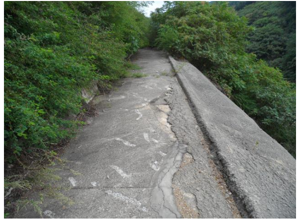
1소단 배수로 전경
