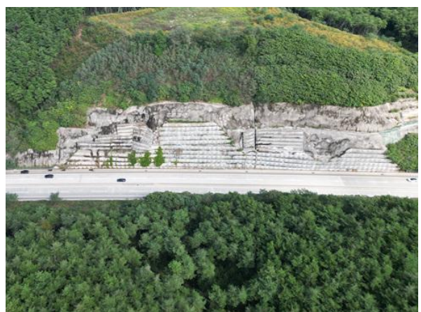
사면내 옹벽 전경
